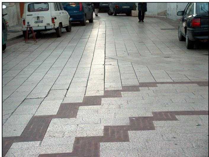
Fig. 6 – Frattura di trazione lungo Corso Margherita
